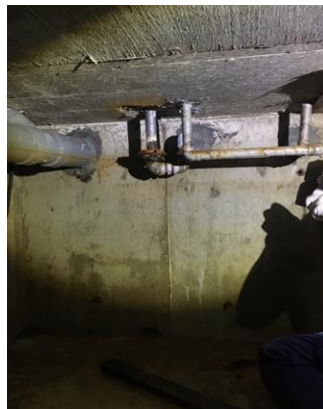
【床下ピット内】
