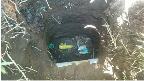
【作業時の掘削穴】
