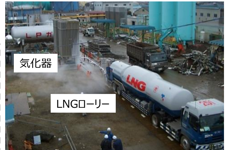
実際の臨時製造の様子 （東日本震災後の石巻ガス）
