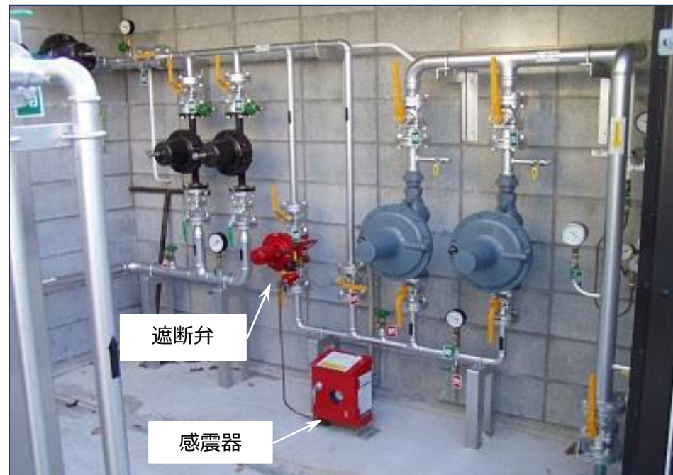
感震自動ガス遮断装置の設置例
