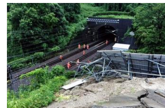
＜太陽光パネルの崩落＞
