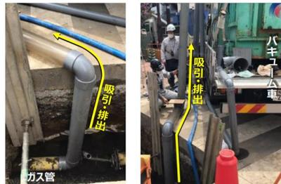
ガス管内の水・土砂の吸引作業例
