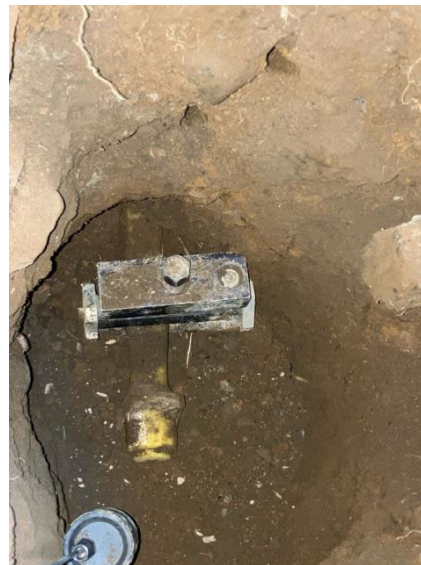
地境切断掘削口 地境切断箇所
