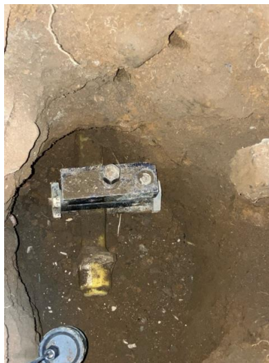
地境切断掘削口 地境切断箇所
