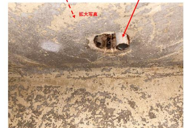
床下ピット内
