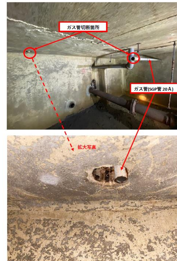
床下ピット内
