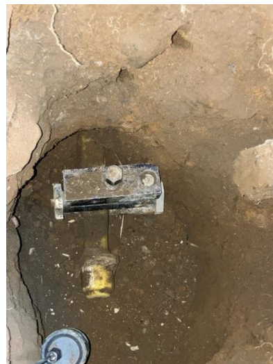
地境切断掘削口 地境切断箇所
