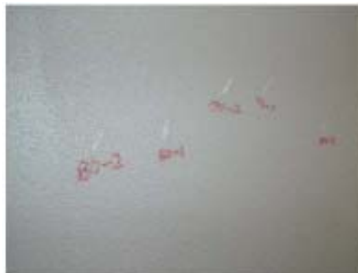
図 1-3-4 損傷状況（表 1-3-2 「番号 12, 13」）
