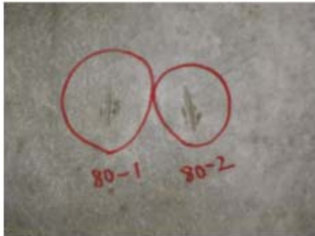
図 1-3-7 損傷状況 (表 1-3-4 「番号 3, 4」)
