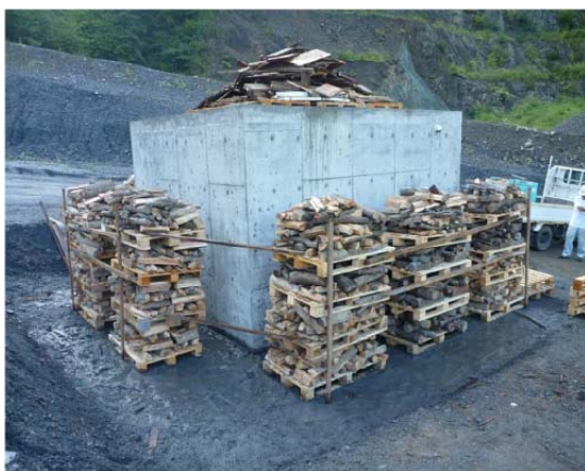
図 2-5 薪の設置状況
