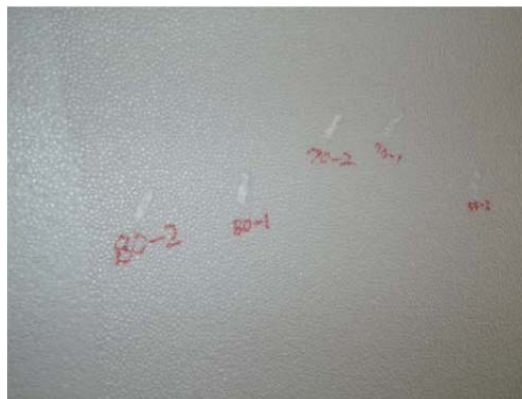
図 1-3-4 損傷状況（表 1-3-2 「番号 12, 13」）
