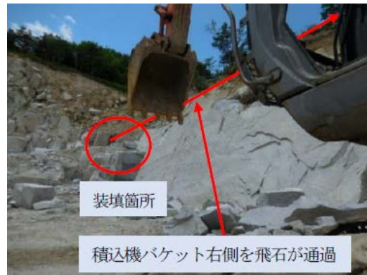
積込機から見た装填箇所方向
