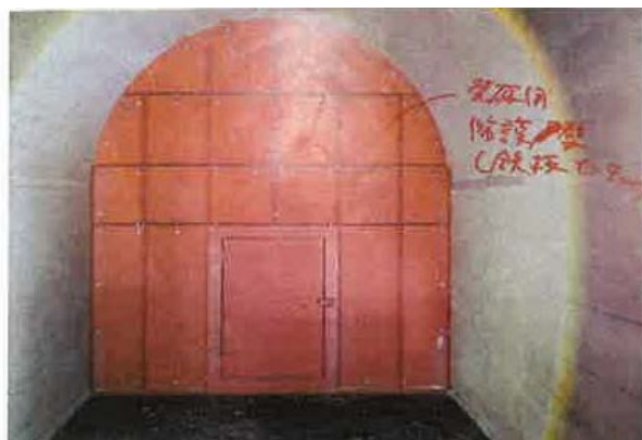
事故発生前の連絡通路防護柵
