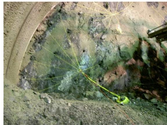
写真 -6 非電気式雷管結線状況 (上半)
