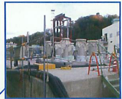
プロパン配管竖坑地上部における 金属配管の据付状況
