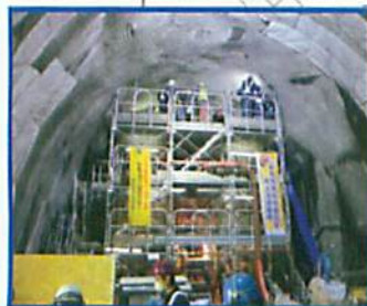
底設プラグコンクリート打設状況
