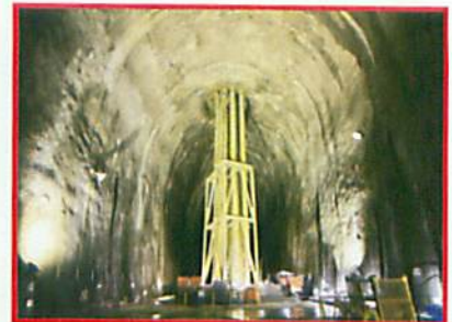
配管竖坑地下部における 金属配管の据付状況
