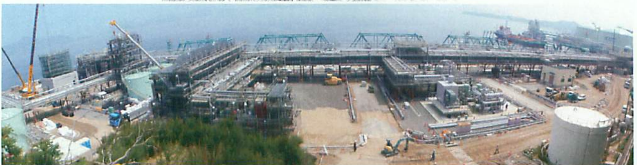
波方基地地上部建設状況
