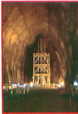
ブタン配管竖坑地下部における 金属配管の据付状況
