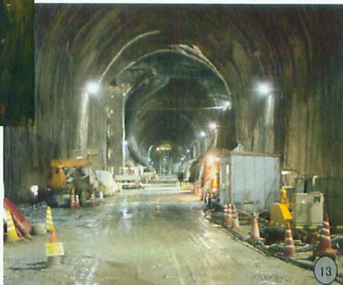
倉敷基地 平成23年3月貯槽掘削 工事完了(高さ24m)
