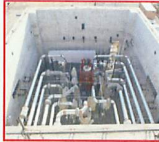
配管竖坑地上部における 金属配管の据付状況
