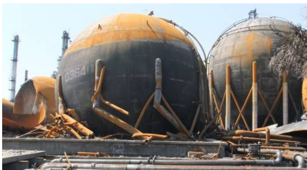
写真 1 倒壊した球形貯槽(事故後撮影)
