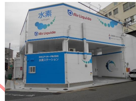
コンパクトな水素ステーションの例 日本エア・リキード 「神戸七宮水素ステーション」
