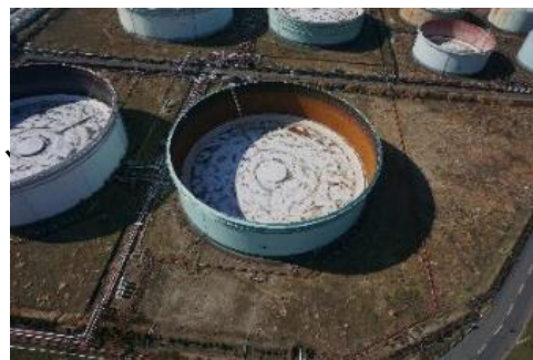
ドローンにより撮影した原油タンク群の浮屋根の画像
