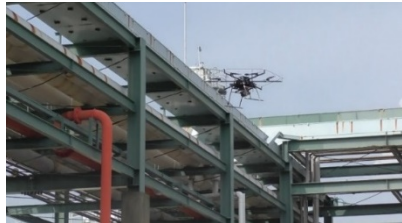
ドローンによる点検の様子
