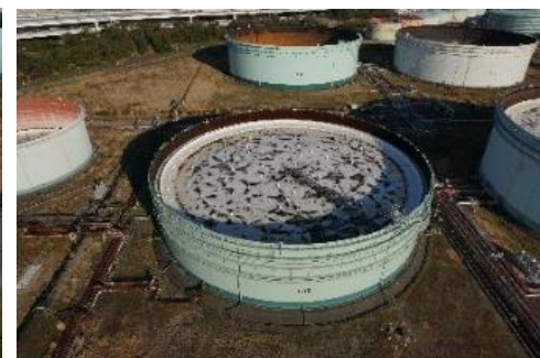
ドローンにより撮影した原油タンク群の浮屋根の画像
