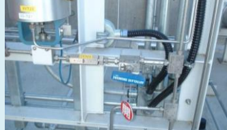
遮断弁、逆止弁
