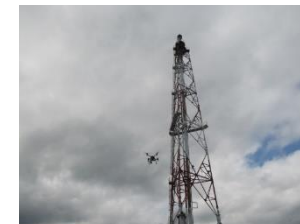
← フレアスタック (活用事例集より引用)
