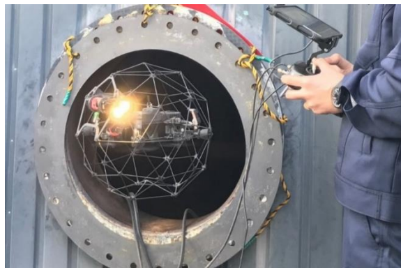
危険物タンクの点検孔に入る様子
