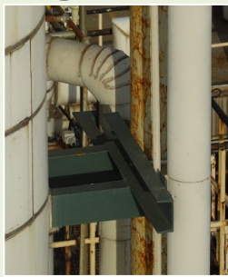
ドローン飛行で 得られた画像 目視では死角に なる接続部分
