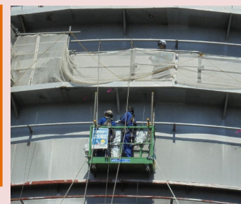
従来のゴンドラを 使った目視点検方法
