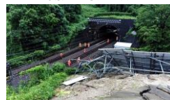
<太陽光パネルの崩落>
