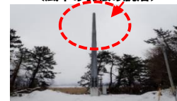
<風車の羽根の脱落>
