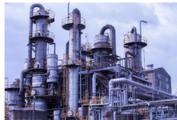
製造施設 外観
