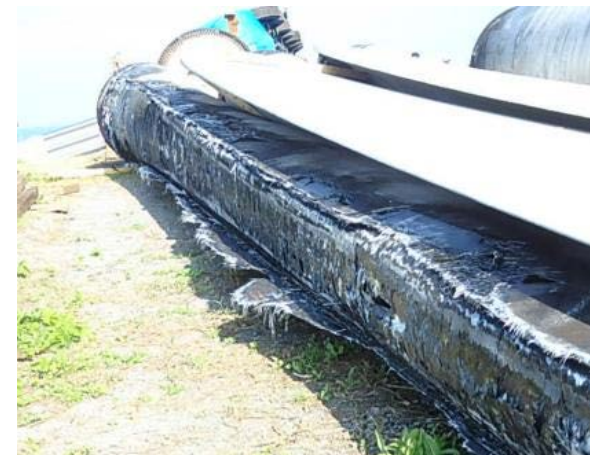
ブレード焼損状況
