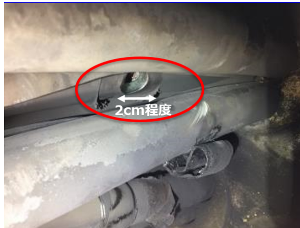
直近点検：異常なし（2016年9月）
