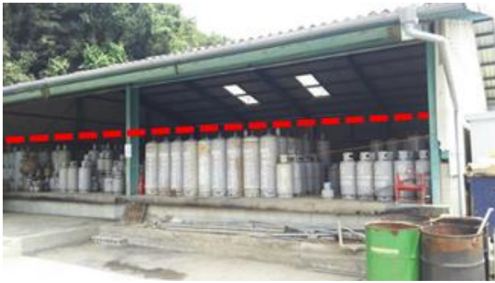
被害を受けた充てん所
