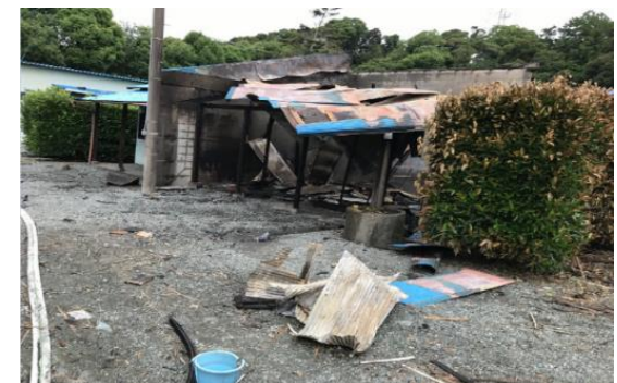
左の部屋の西側危険工室
