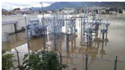
水没した変電所（長野県千曲市）
