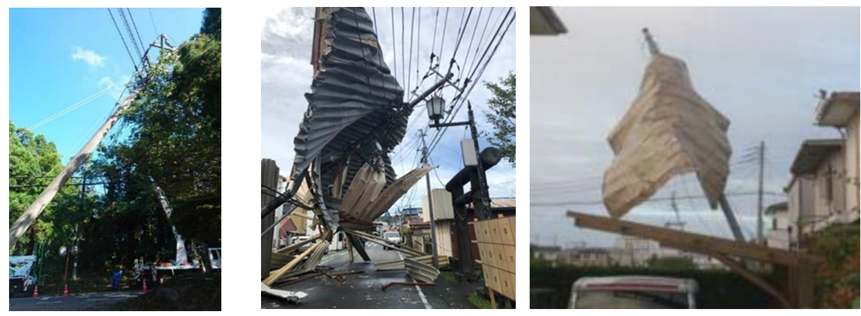
損壊現場の様子（倒木及び飛来物による損壊）
