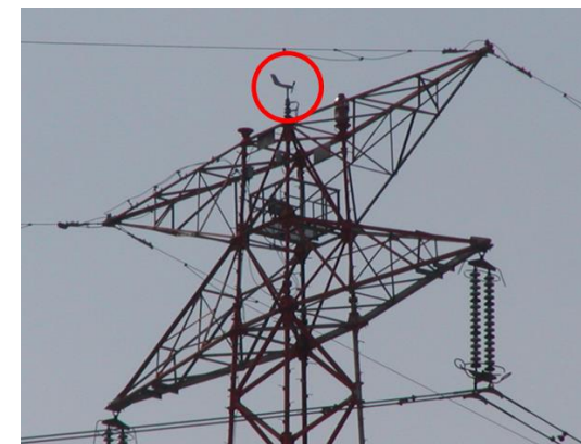
鉄塔頂部に風速計を設置
