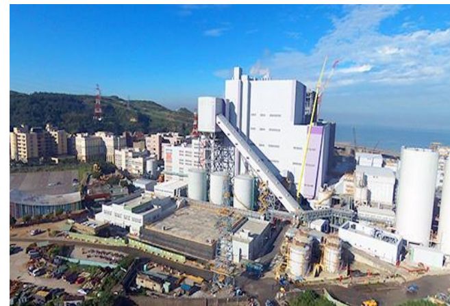
台湾電力の林口火力発電所
