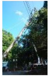
<倒木・飛来物による電柱損壊現場の様子>
