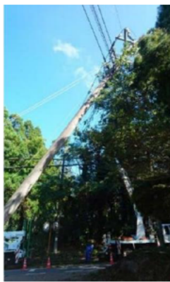
倒木・飛来物による電柱損壊
