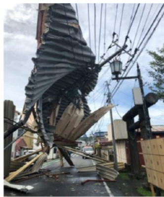
倒木・飛来物による電柱損壊
