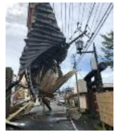
<倒木・飛来物による電柱損壊現場の様子>
