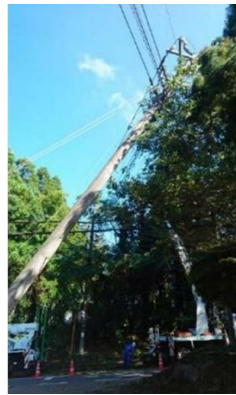
倒木・飛来物による電柱損壊
