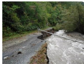
倒壊した電柱
