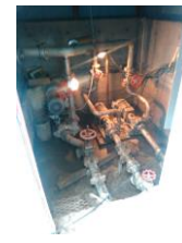
水没したポンプ
