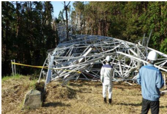
転倒した鉄塔
