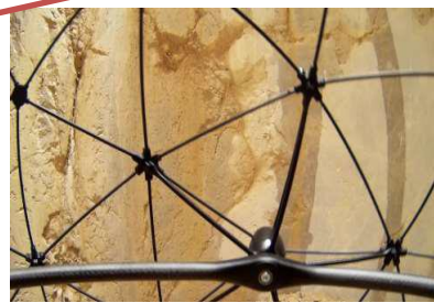
ドローンにより撮影した立坑壁面
