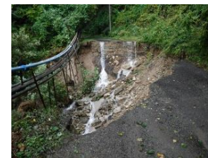
崩落した道路
