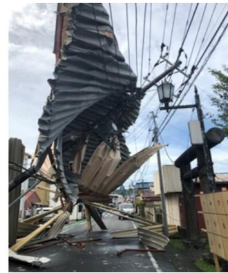
倒木・飛来物による電柱損壊
