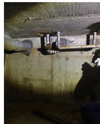
【床下ピット内】
