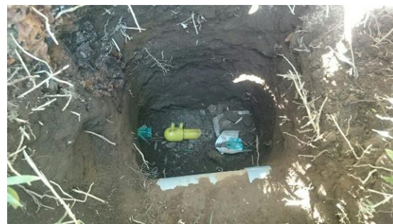
【作業時の掘削穴】
