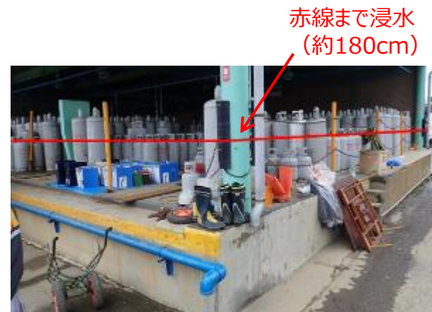
被害を受けた充てん所
