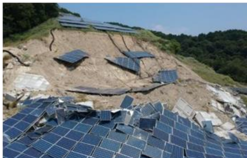
<太陽電池パネルの飛散>
