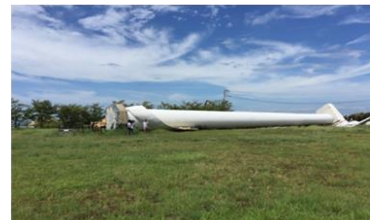
<風力発電設備の倒壊>
