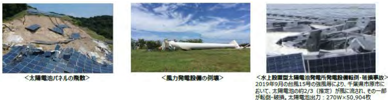
【図 37】再生可能エネルギー発電設備の事故
