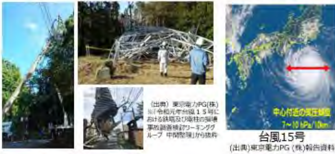
台風15号の被害(転倒した鉄塔/倒木・飛来物による電柱損壊)
