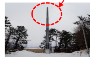
＜風車の羽根の脱落＞
