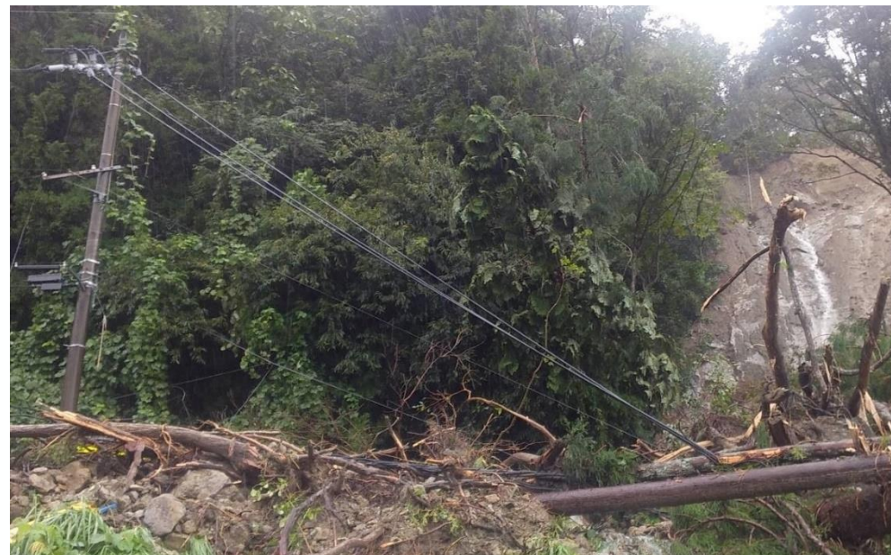
被害状況（電柱倒壊）
