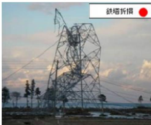
津波により折損した鉄塔
