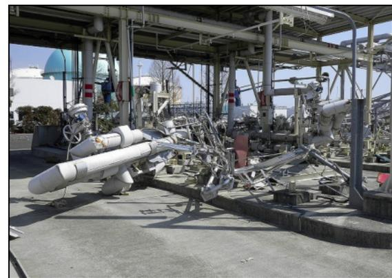
津波によるガス製造設備の破損
