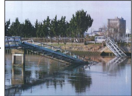
漂流物(浚渫船)の衝突による中圧導管の損傷
