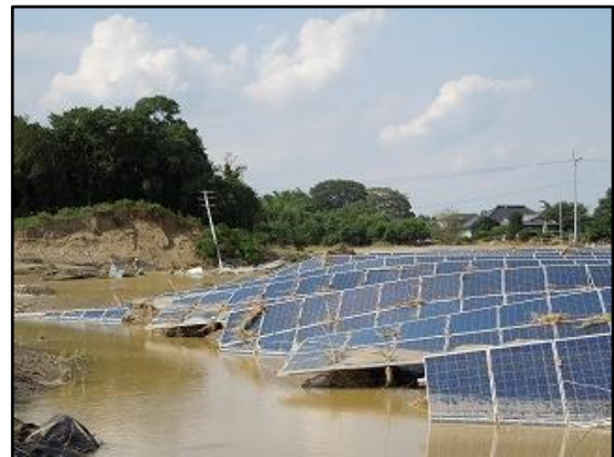
平成27年9月 茨城県 鬼怒川の決壊に伴う太陽光発電設備の水没
