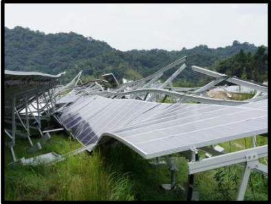
【群馬県 突風被害（400kW）】 【九州 台風15号被害（1,990kW）】
