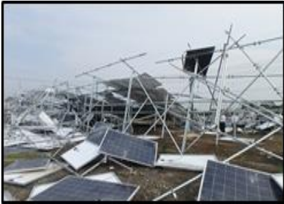
【群馬県 突風被害（400kW）】 【九州 台風15号被害（1,990kW）】
