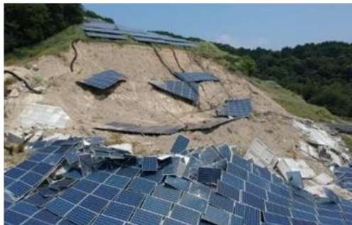
＜太陽電池パネルの飛散＞
