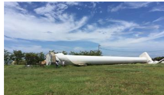
＜風力発電設備の倒壊＞
