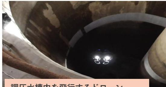
調圧水槽内を飛行するドローン
