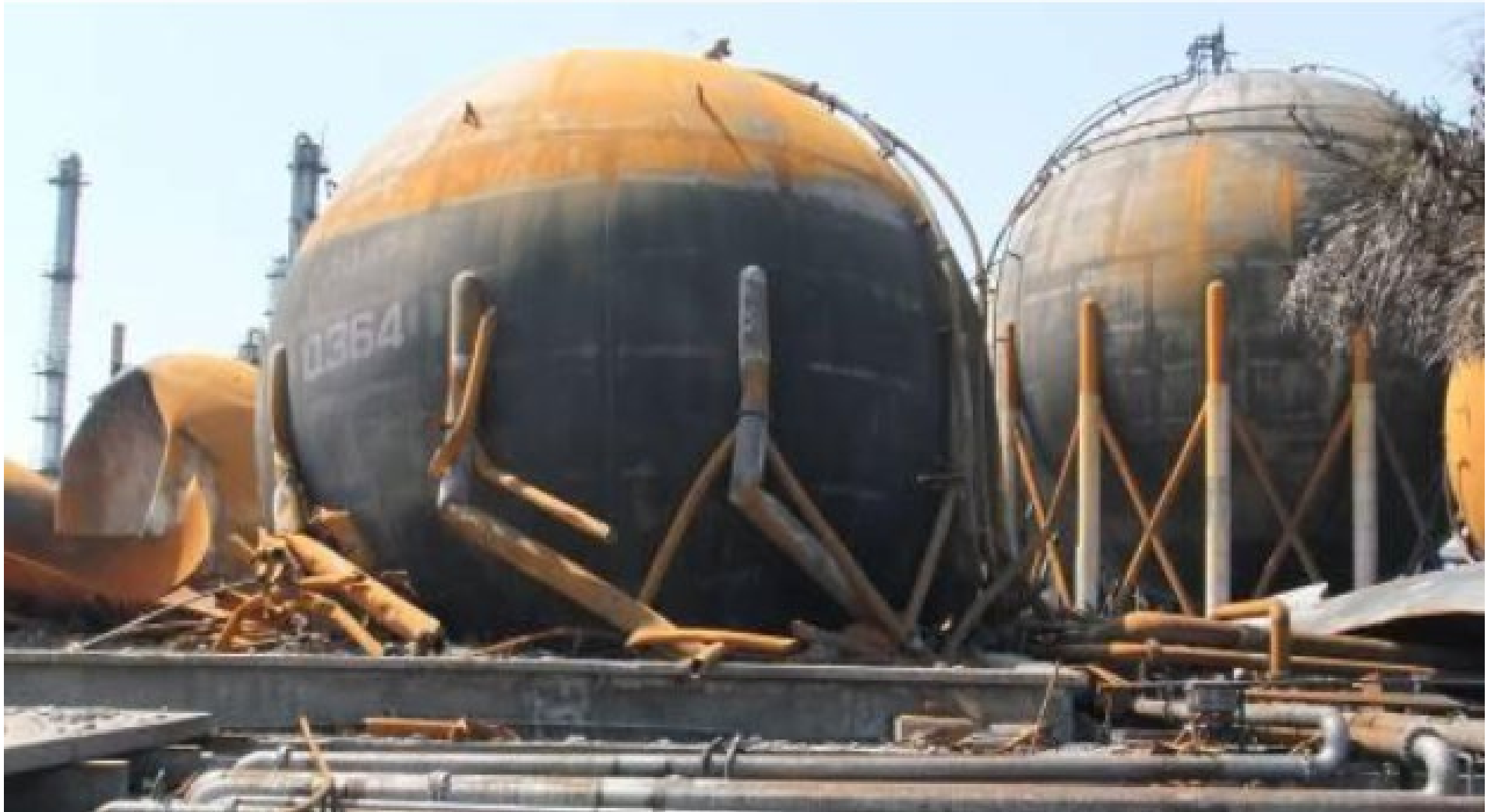
倒壊した球形貯槽(事故後撮影)
