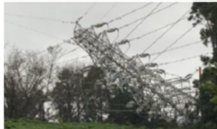
台風15号で倒壊した鉄塔（千葉県君津市）
