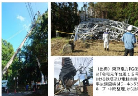
台風15号の被害（転倒した鉄塔／倒木・飛来物による電柱損壊）
