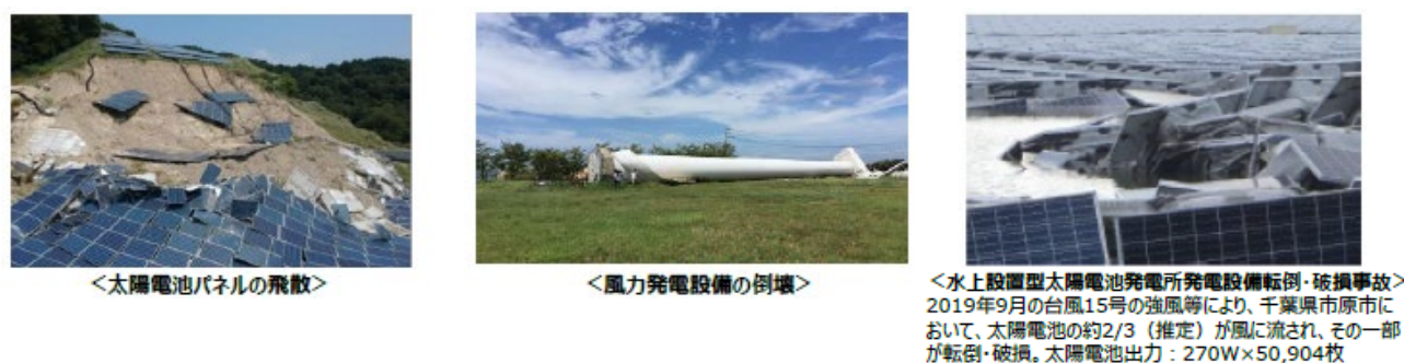
【図26】再生可能エネルギー発電設備の事故
