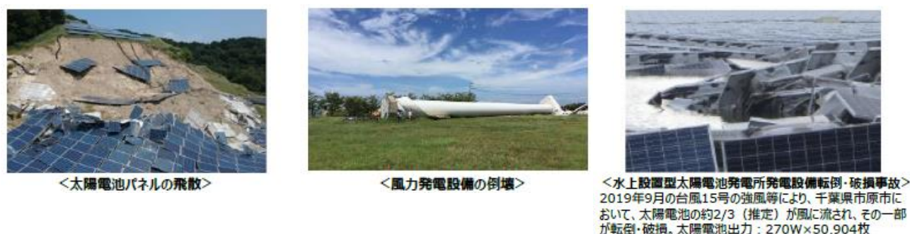
【図 35】再生可能エネルギー発電設備の事故
