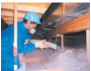
天井の断熱改修
