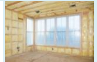
天井・壁・床等の断熱改修
