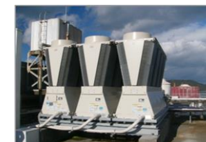
高効率空調設備 （チリングユニット）
