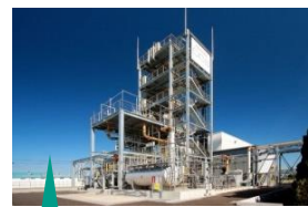
二酸化炭素分離回収設備
