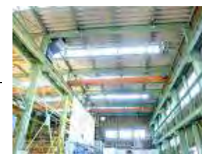
工場屋根の明かり取り窓
