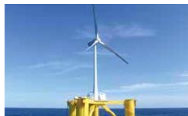
浮体式洋上風力発電システム (福島県沖) (提供: 福島洋上風力コンソーシアム)
