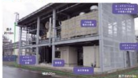
Fig.2 メタネーション実証試験装置の外観
