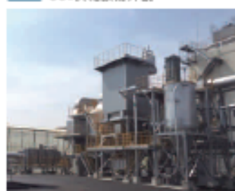
Fig.1 CO 2 供給設備外観
