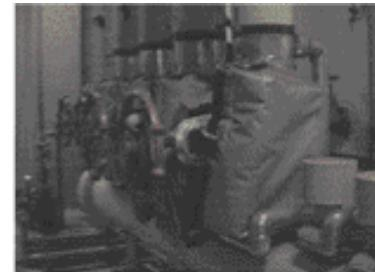
保温ブラケット・保温カバー等の装着により、放熱を回避。エネルギー効率を改善し、エネルギー使用量を削減する。
